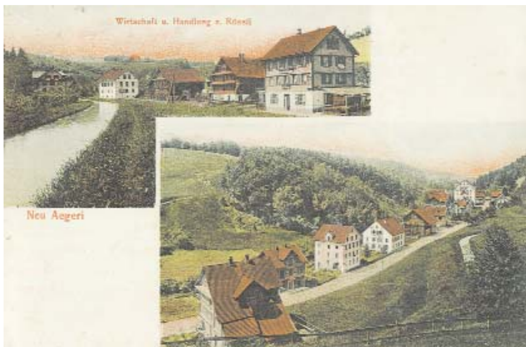
Bild 340 Ansichten von Neuägeri und dem Fabrikkanal, um 1900. Der Kanal folgt zuerst der Kantonsstrasse (links) und führt das Lorzenwasser nach Unterquerung der Strasse dem Hang entlang (rechts) bis zum Wasserschloss oberhalb der Spinnerei im Hintergrund. Unterhalb des Kanals ist noch der Verlauf der früheren, tiefer gelegenen Rinne erkennbar.
