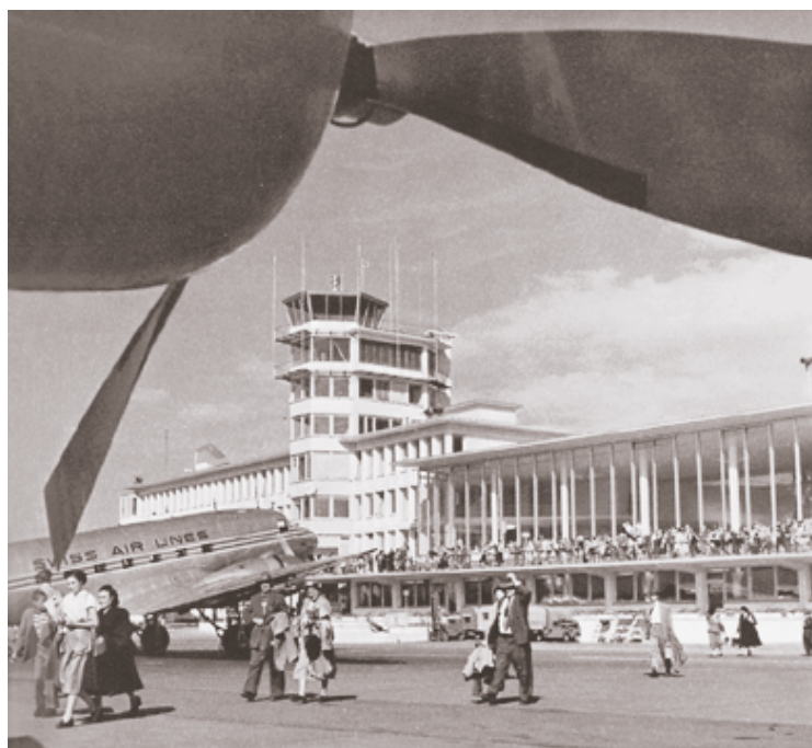
Bild 135 Flughafen Zürich-Kloten, 1950er Jahre. Da der neue Flughafen das Gelände des Artilleriewaffenplatzes Kloten beanspruchte, verlangte die Armee einen gleichwertigen Ersatz, der vermeintlich im Gebiet Ägeri-Rothenthurm gefunden wurde. Die damit in ihrer Existenz bedrohte Korporation Oberägeri und ihre Pächter wehrten sich vehement dagegen, ebenso die Ägerer Kur- und Tourismusbetriebe. Das Projekt wurde schliesslich aus Kostengründen aufgegeben.
